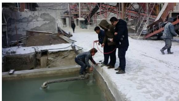
砂石料系统废水监测采样
