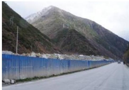
图 5.6-1 渣场隔声围挡建设情况
