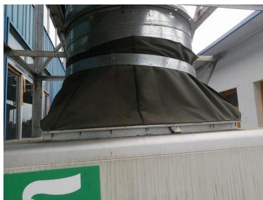
排风装置风管连接用软接头
