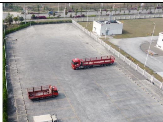
东侧停车场地坪硬化
