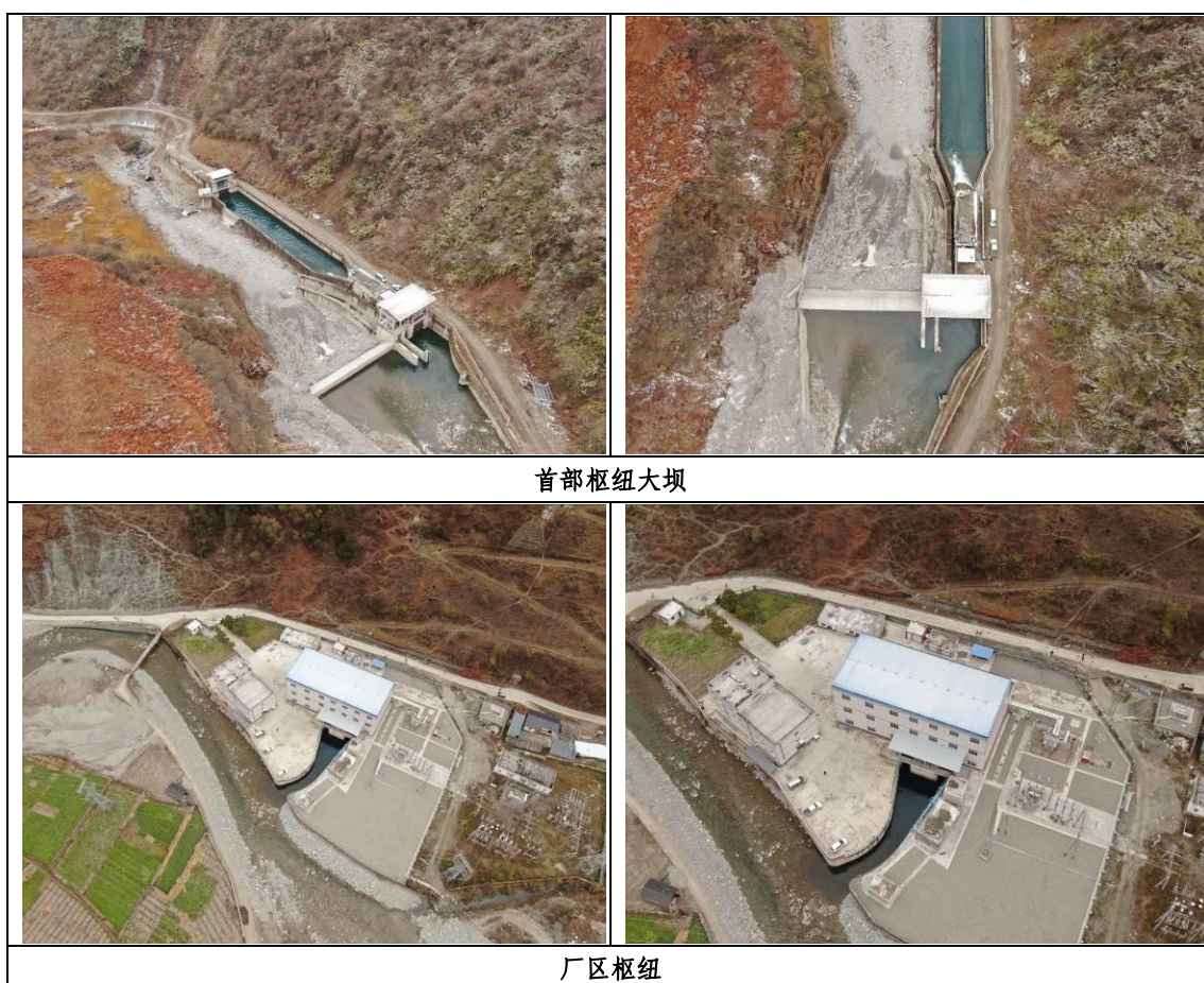
图1-2 主体工程现状
