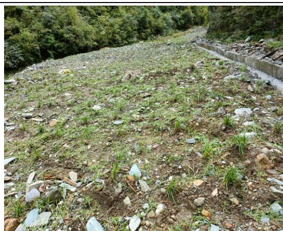
4#弃渣场渣顶绿化及内侧排水沟
