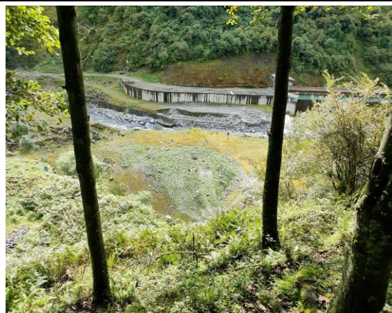
1#临时弃渣场及施工生产生活区迹地恢复
