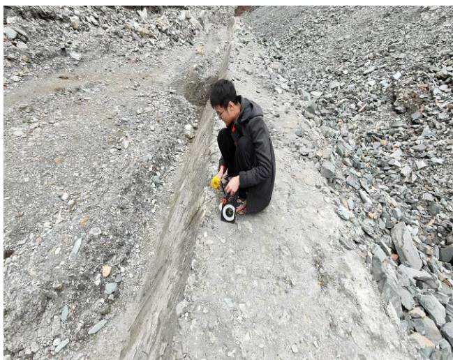
弃渣场挡渣墙结构尺寸调查监测
